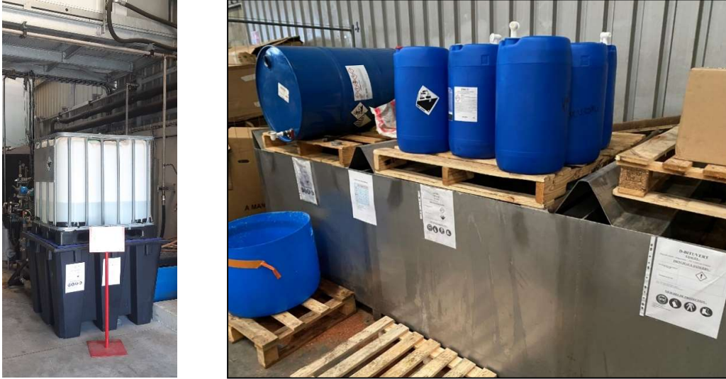
Figure 1. Photographies des rétentions des produits (à gauche : savon à la soude, à droite : produits de nettoyage)
